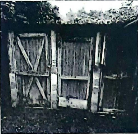
Foto 1: mejoramiento de puertas de lamina con madera por puertas de metal.
